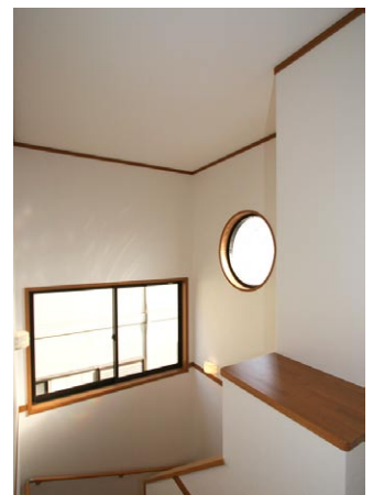
吹抜け階段の上部に丸窓をつくり、採光性を高め、外観のアクセントにもしています
