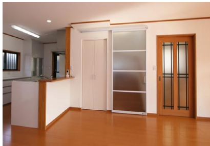
1階は玄関建具をはじめすべて引き戸を使ったバリアフリー設計です
