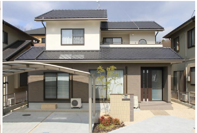
幅広い年齢層から支持される和モダンの外観。瓦は三州産の平板陶器瓦、壁の汚れを雨で洗い流すセラミック外装材を使用しています
